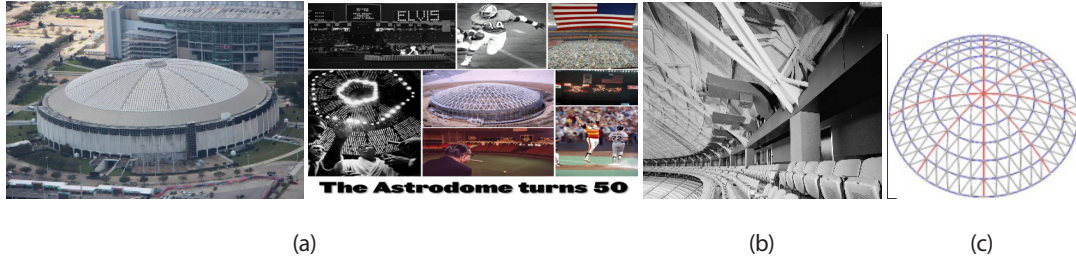
Şekil 10. (a) 217 m açıklıklı Kiewitt kubbe Astrodome, Houston, A.B.D, 1965 [13]; (b) kafesler ve mesnet birleşimleri [14]; (c) Kiewitt kubbe görünümü (Yan ve diğerleri, 2016)
