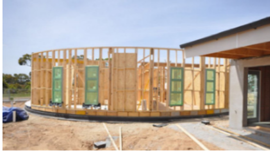
Şekil 19. Yapının ahşap strüktürü (URL 11)
