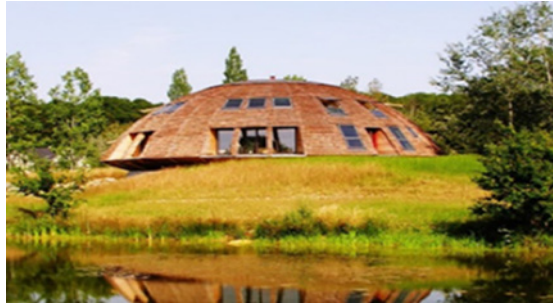
Şekil 1. Yapının ahşap iskeleti (URL 1)
