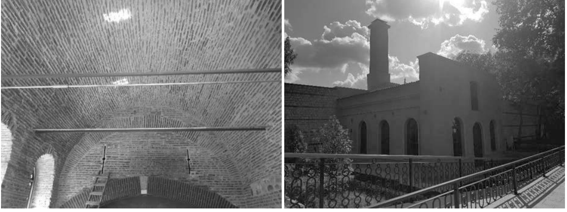
Şekil 4: Kağıthane Tarihi Çamaşırhane Binası gergi uygulaması (Yazarın Fotoğraf Arşivi)
